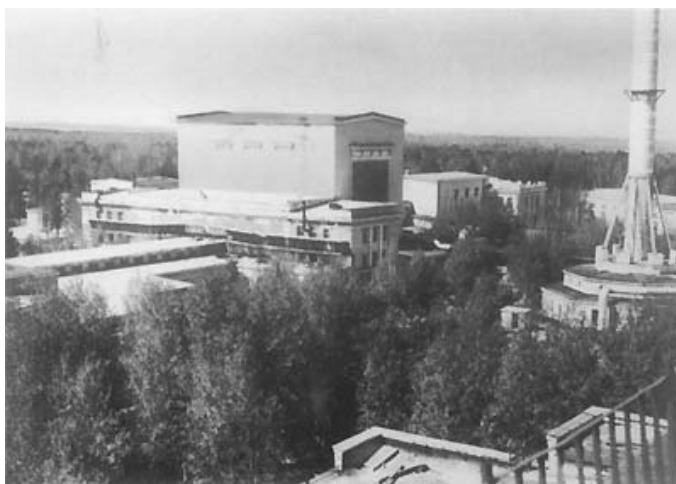
Здание первого реактора Аннушка
