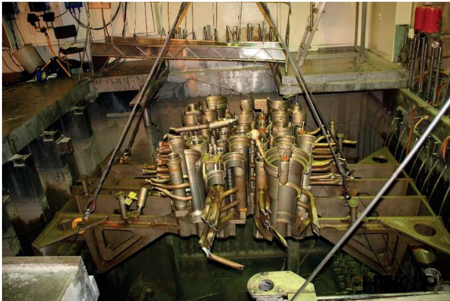
*Рис. 6 – Удаление опорной решетки реактора МР*
