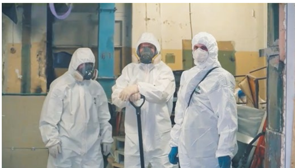
Рисунок 2.2.12 – Техтур на площадку АО «ВНИИНМ», г. Москва. На фото специалисты, выполняющие работы по ВЗ ЯРОО
