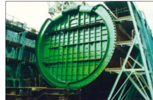
Рис. 4.77. Формирование реакторного блока
