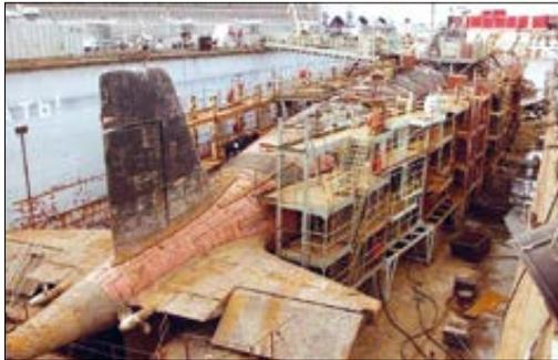
Рис. 4.67. Демонтаж конструкций в плавдоке
