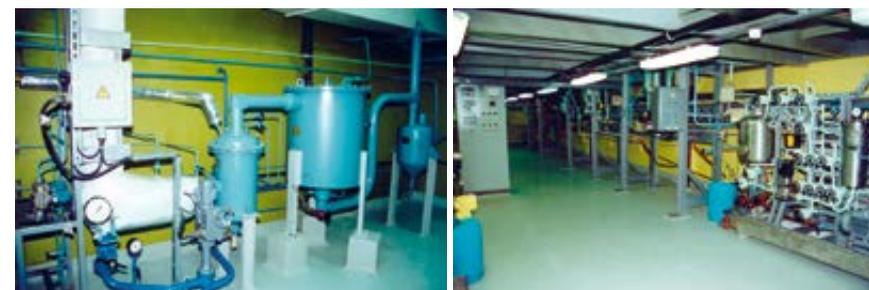
Рис. 5.29. Установки по переработке ЖРО
