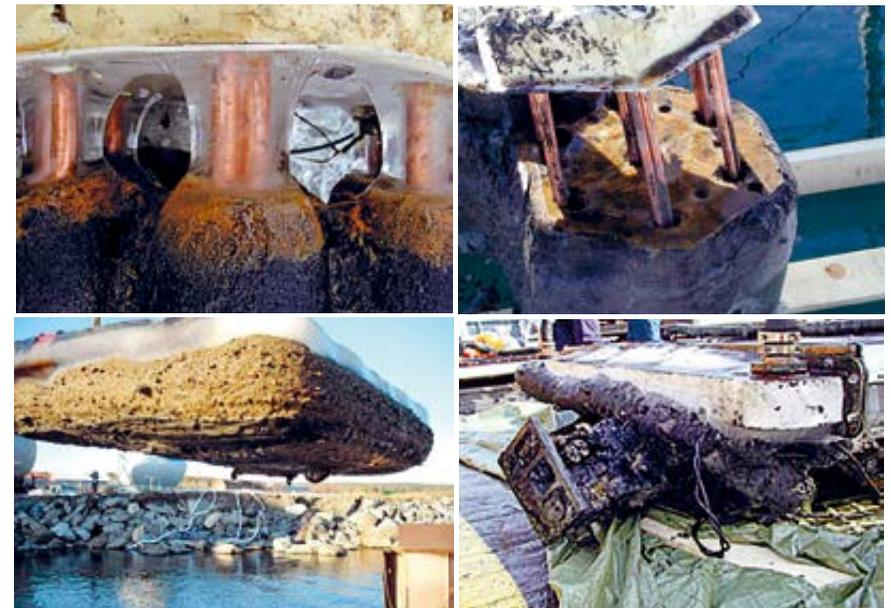
Рис. 4.36. Извлечение грунта с техническими малоразмерными конструкциями на мелководье с помощью вертикальной и плоской замораживающих ячеек [388]
