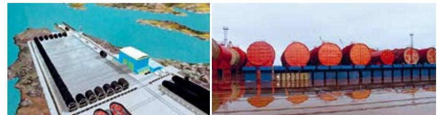
Рис. 4.82. Размещение блока РО в пункте длительного хранения «Сайда-губа»
