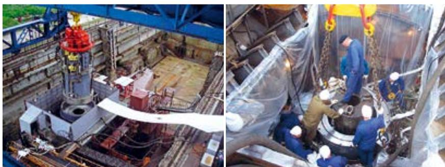
Рис. 5.21. Установка разгрузочного скафандра на реактор АПЛ
