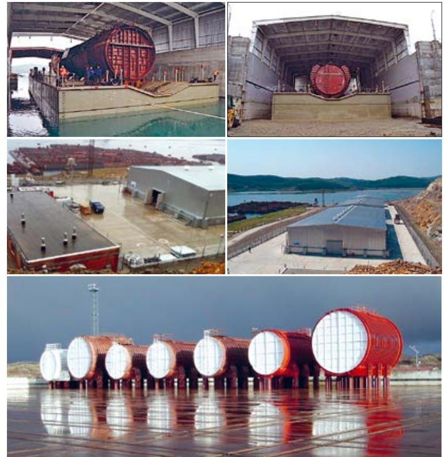
Рис. 4.84. Основные этапы принятия объекта с аварийным реактором: ввод реакторного отсека по каналу в сооружение, откачка воды и бетонирование фундамента, внешний вид укрытий радиационно опасных объектов для длительного хранения на берегу в ПДХ в бухте Разбойник (Приморский край). Внизу: не требующие укрытия РО располагают на открытой площадке
