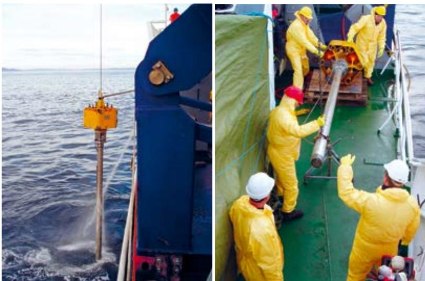
Рис. 2.36. Отбор кернов донных отложений грунтовой трубкой с борта НИС НАТО «Альянс» [60; 309]
