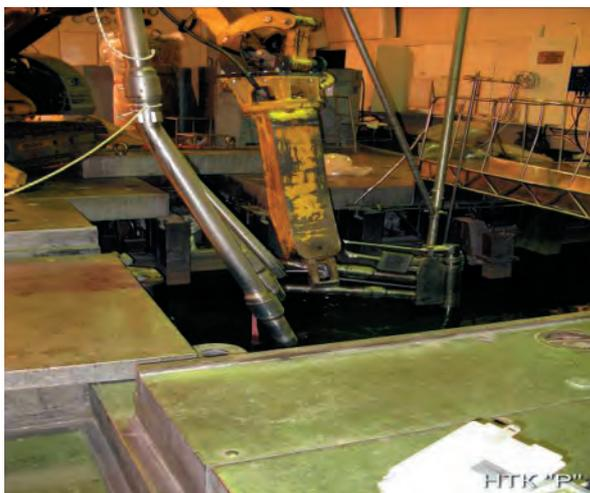
*Рис. 4.5.3.11. Отделение подводящих и отводящих трубопроводов от канала*
