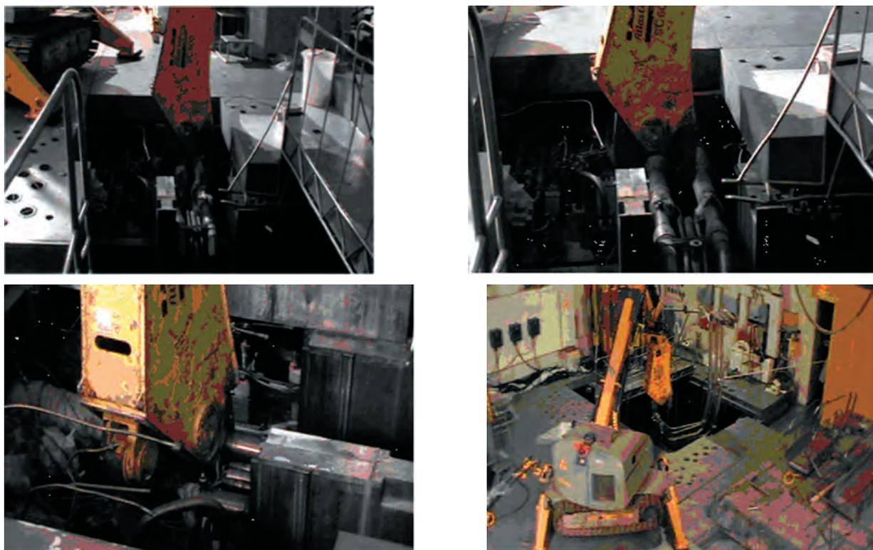
Рис. 4.5.3.10. Отсоединение канала от петлевой установки ПВМ
