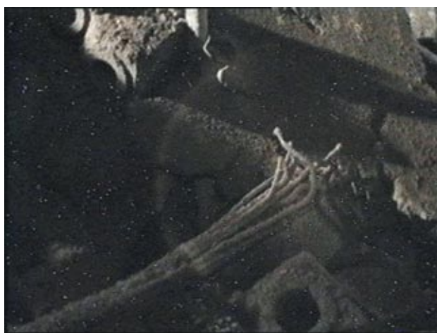
Рис. 5.2. Пучок разрушенных ТВЭЛов в пом. 305/2 объекта «Укрытие»
