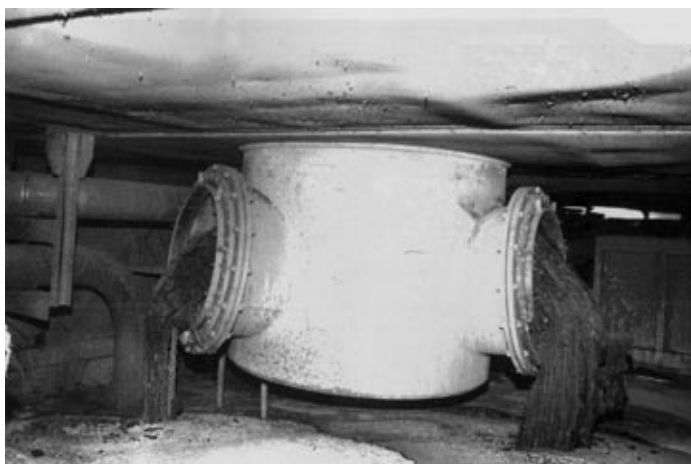
Рис. 7.24. Помещение 210/7, клапан 4 (фото и прорисовка). Съемка проводилась с юго-западной стороны из патрубка 3 (справа), из которого вытекает коричневая лава (на полу под ним в виде застывшего натека наблюдается металл); в патрубке 1 (слева) струи металла перемешаны с застывшим потоком шоколадно-коричневой керамики
