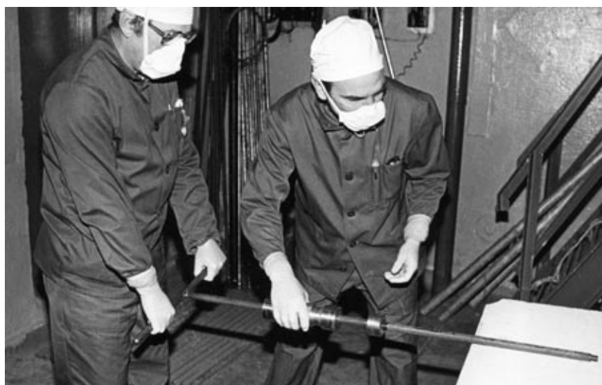
Рис. 3.9. Подготовка к отбору пробы через скважину
