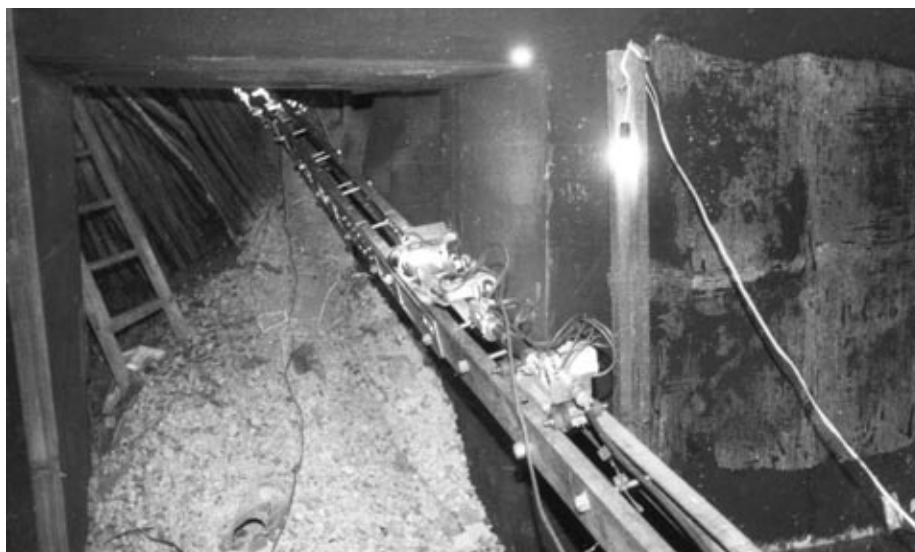
Рис. 7.3. Робот-разведчик, оснащенный телекамерой, осветительными и другими приборами, на пути в пом. 305/2
