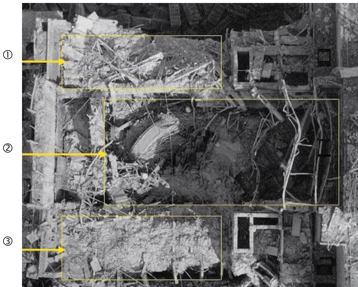
Рис. 4.3. Верхние отметки блока после аварии. ① и ③ — завалы на потолках помещений северного и южного барабанов-сепараторов, ② — центральный зал
