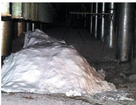
Рис. 7.30. «Куча» в ББ-1 после нанесения слоя ЭКОР
