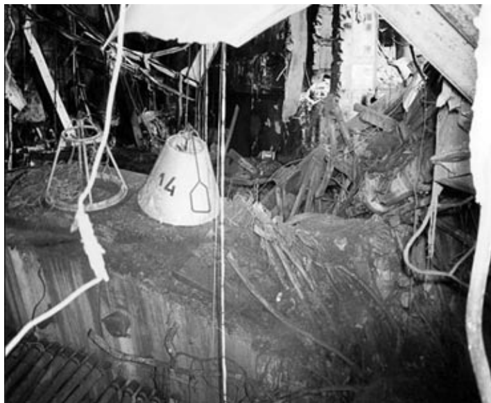
Рис. 2.6. Буй, установленный в развале центрального зала 4-го блока на ребре схемы «Е»
