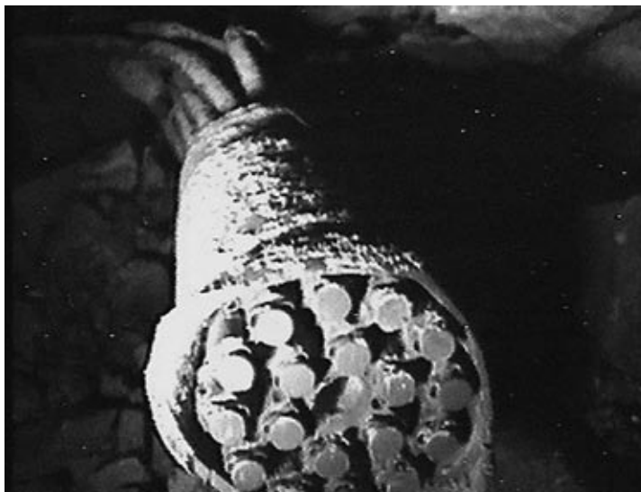
Рис. 4.7. Фрагмент ТВС в подаппаратном помещении (пом. 305/2)
