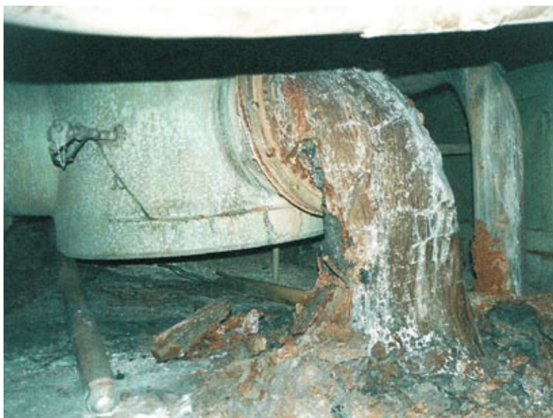
Рис. 7.22. Застывшие струи ЛТСМ, вытекающие из парораспределительного клапана в пом. 210/7
