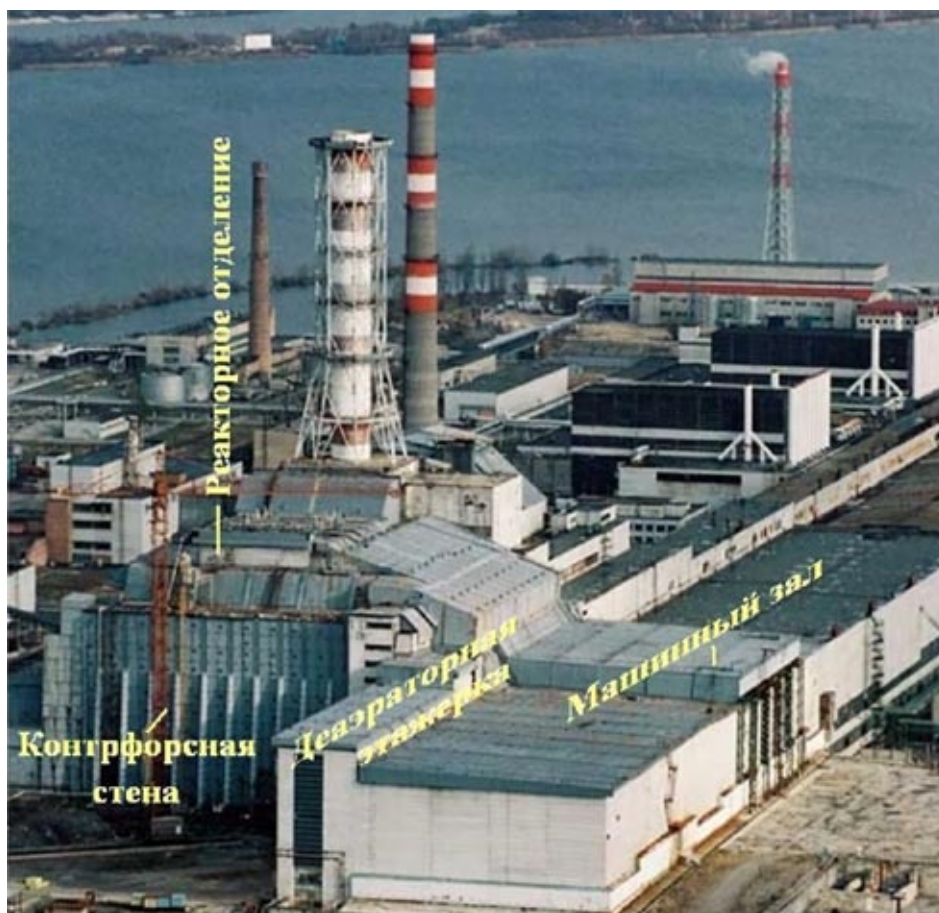
Рис. 2. Объект «Укрытие». Вид с запада, 1995 г.
