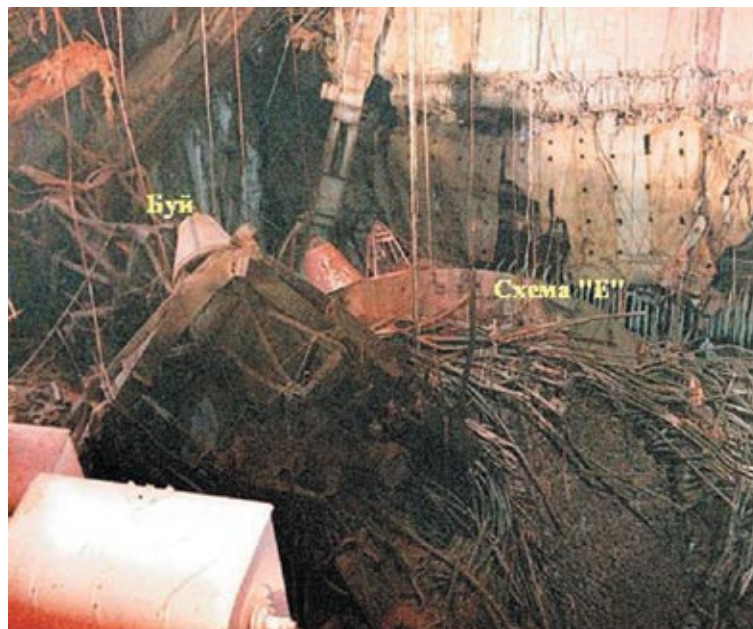
Рис. 4.5. Верхняя плита биологической защиты реактора (схема «Е») вместе с трубами пароводяных коммуникаций, остатками технологических каналов и обломками железобетонных конструкций
