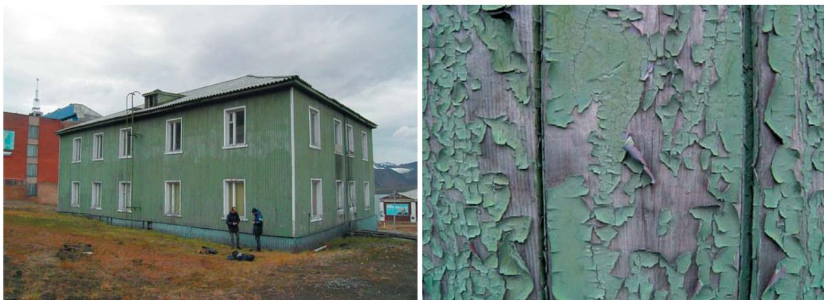
Рис. 2. Деревянное здание и фрагмент наружной стены, с которой брались образцы краски (точка № 43)
