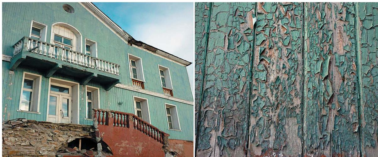
Рис. 3. Здание старого консульства и фрагмент наружной стены, с которой брались образцы краски (точка № 31)
