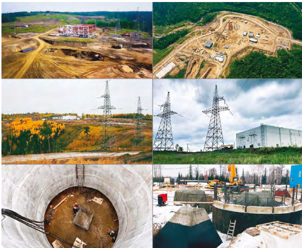
Рис. 2. Площадка строительства подземной исследовательской лаборатории на участке Енисейский
