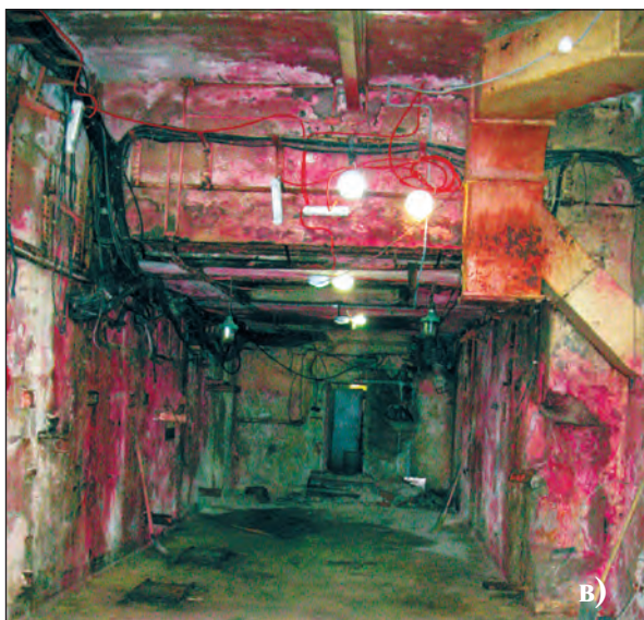
Рис. 4.1.12. Демонтаж реакторного оборудования в РНЦ КИ: а — начало работ; б — применение робототехники; в — после демонтажа оборудования
