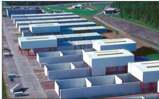
Рис. 2.3.4. Камеры с подвижными крышами на площадке CSA
