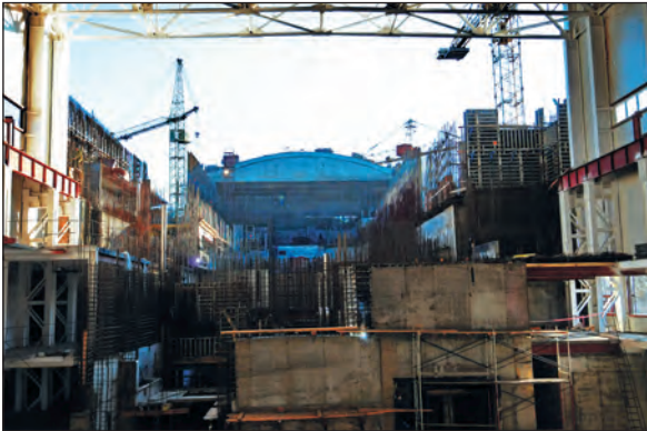
Рис. 4.1.4. Строительство пускового комплекса сухого хранилища – осень 2009 года
