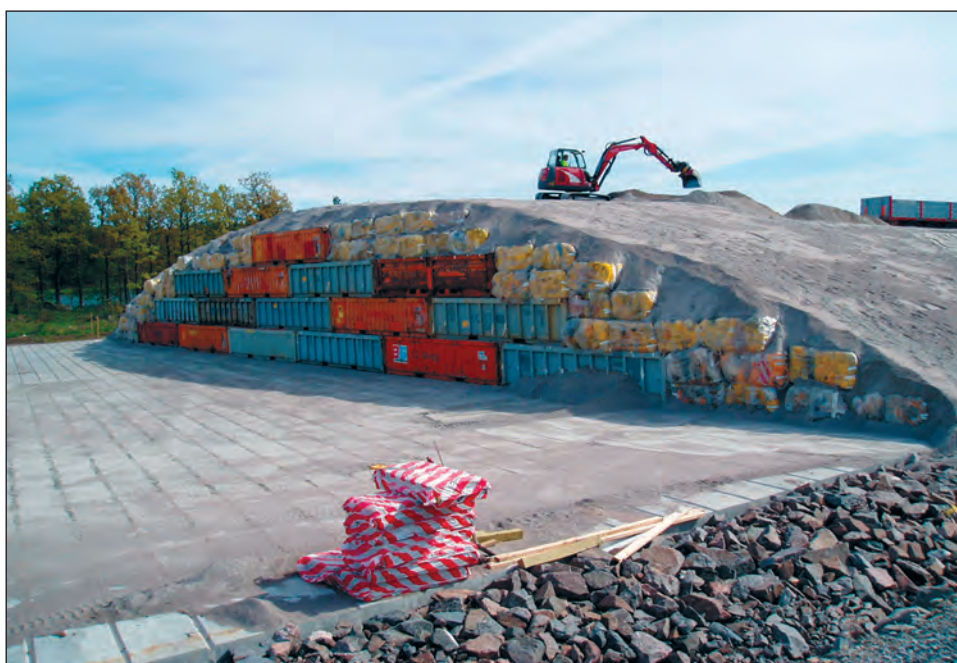
Рис. 2.3.2. Пункт захоронения ОНАО в ходе кампании по загрузке
