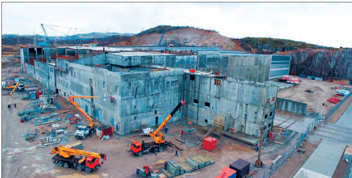
Рис. 4.5.4. Строительство регионального центра кондиционирования и хранения РАО в губе Сайда по состоянию на октябрь 2012 г.
