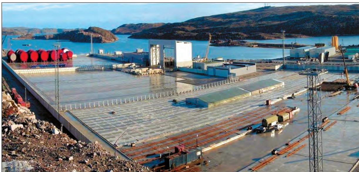
Рис. 4.5.3. Береговой пункт долговременного хранения реакторных отсеков по состоянию на июнь 2011 г.
