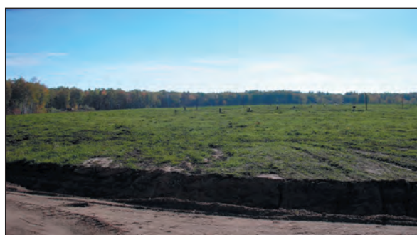
Рис. 4.2.2. Состояние бассейна Б-2 после консервации
