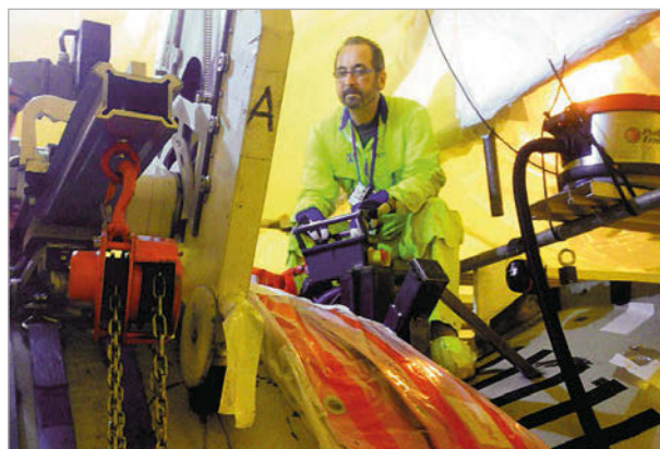
Рис. 2. Удаление загрязненного слоя металлического узла [17]
