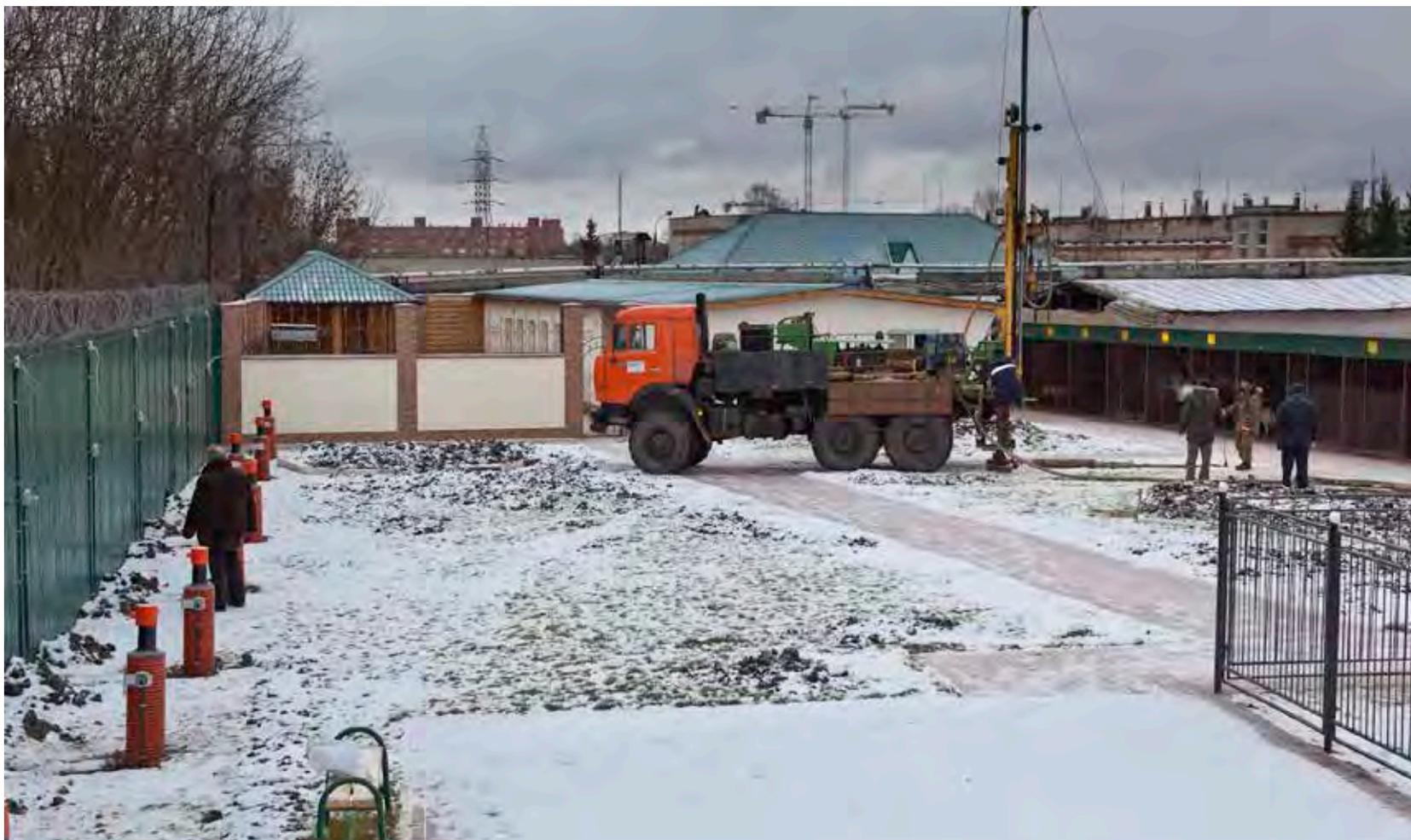
Рис. 2. Территория Кинологического центра. Вид с запада. Бурение разведочных скважин с отбором проб около административного здания. Слева – наблюдательные скважины с установленными в них датчиками автоматизированной системы контроля радиоактивности грунтовых вод.
