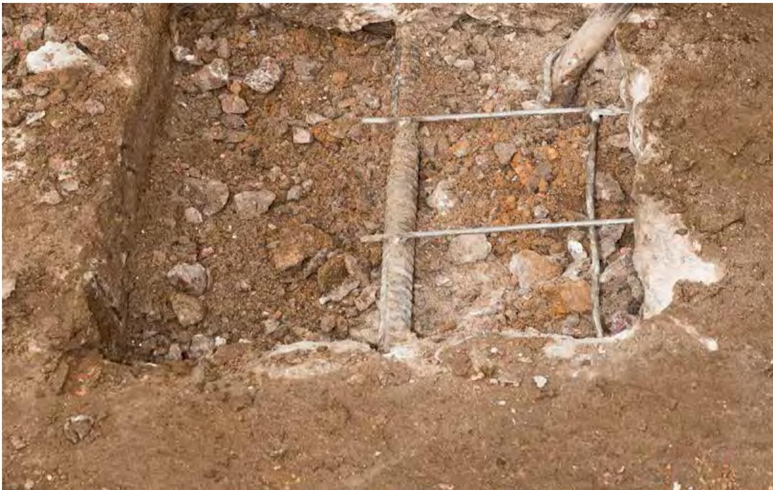
Рис. 3. Участок железобетонного покрытия на бункере захоронения радиоактивных отходов ЗМРП, на котором после вырезания поверхностной арматуры проводилось бурение
