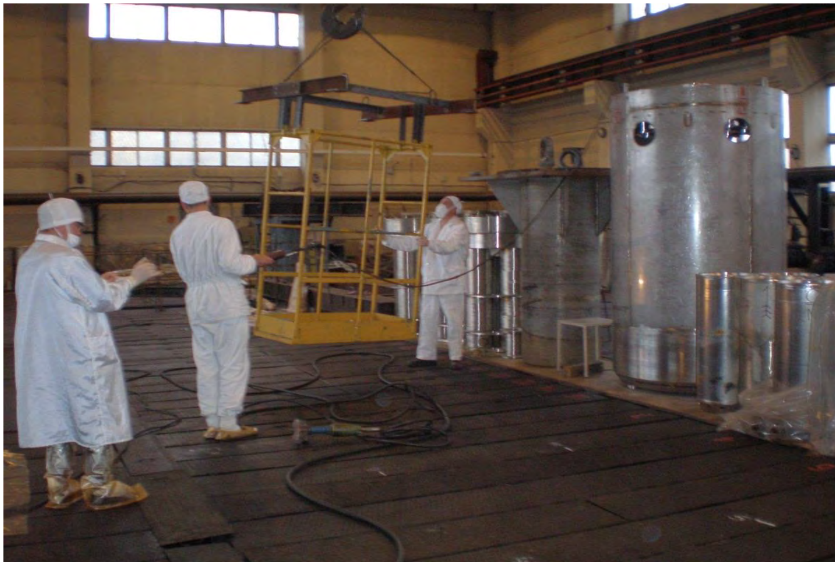
Мобильная площадка для производства работ по вырезке темплетов
