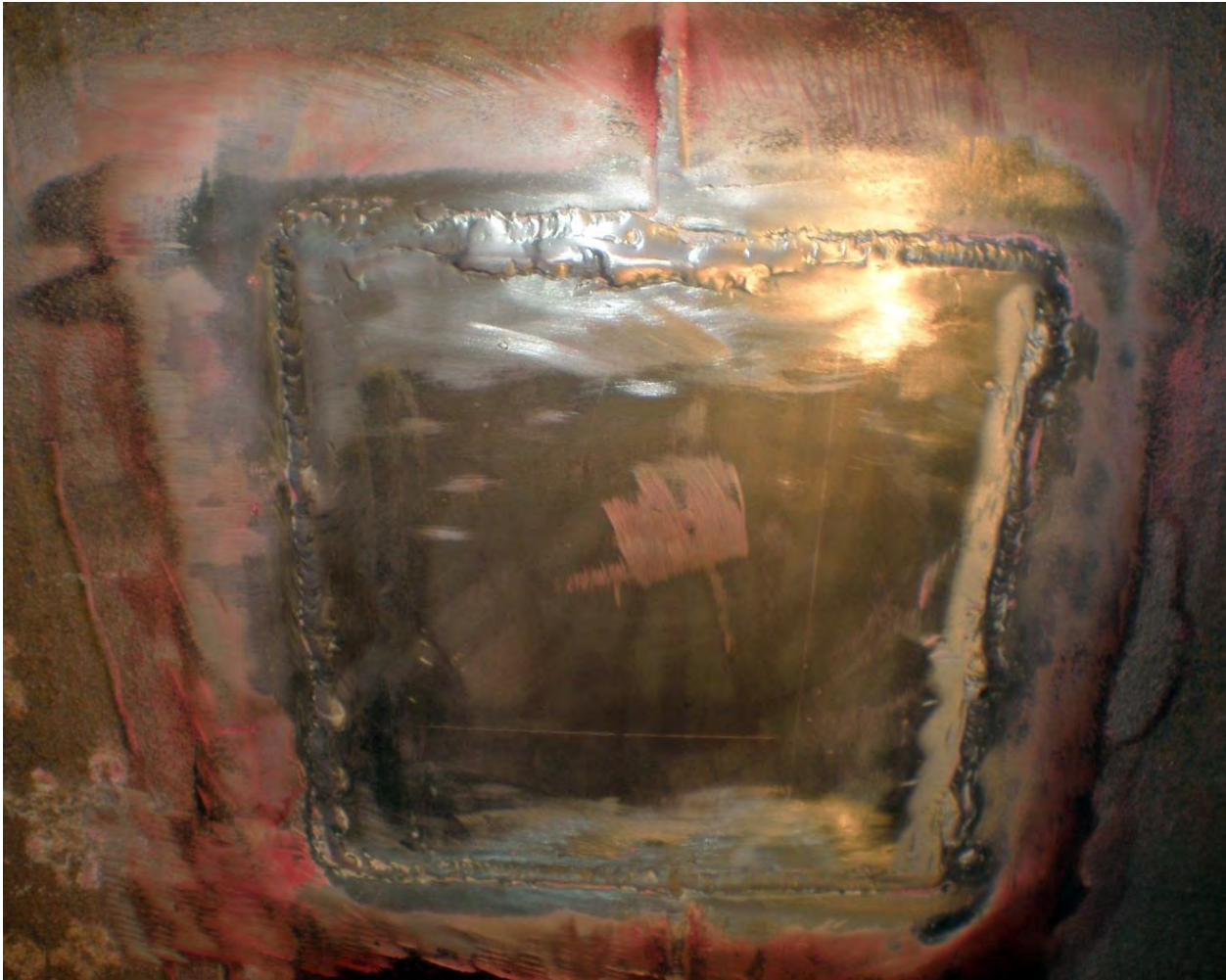
Фото 24. Проверка качества сварки заплатки на месте вырезки темплета №3.
