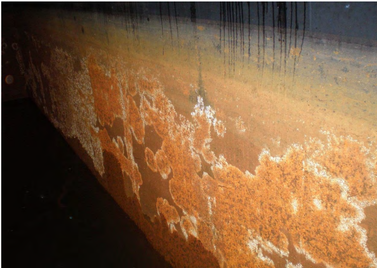
Вид внутренней стены БВ 2 после снижения уровня воды.
