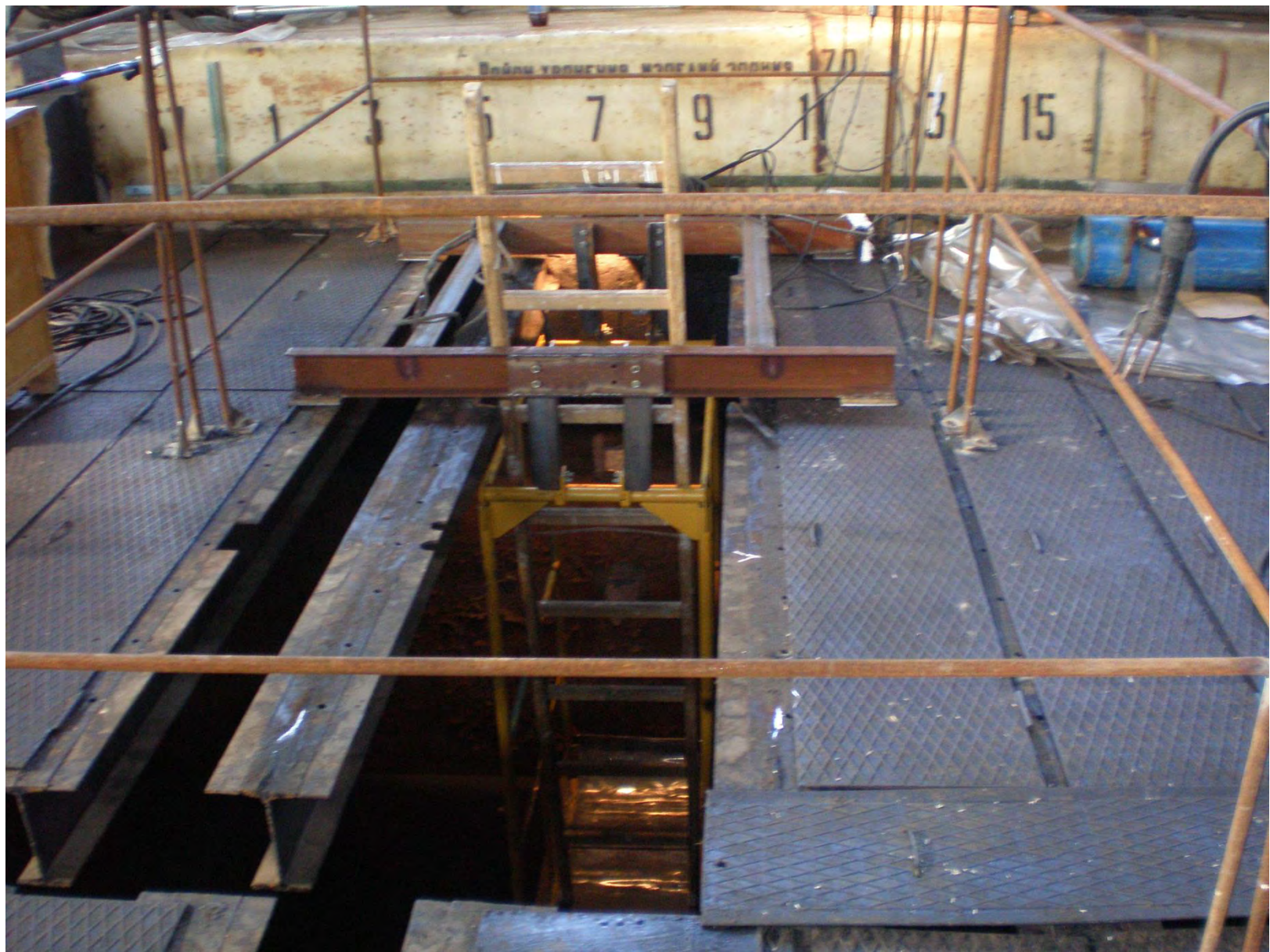
Место вырезки темплетов №1 (тип А) и №2 (тип Б) с установленной площадкой для проведения работ
