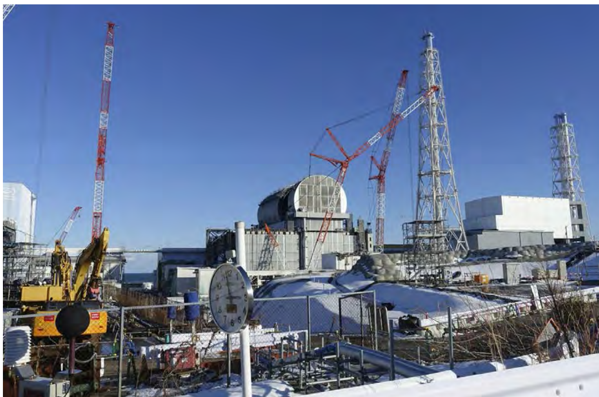
Рис. 108. «Изолирующий кожух» смонтирован над 3-им блоком (справа виден 4-ый блок).
