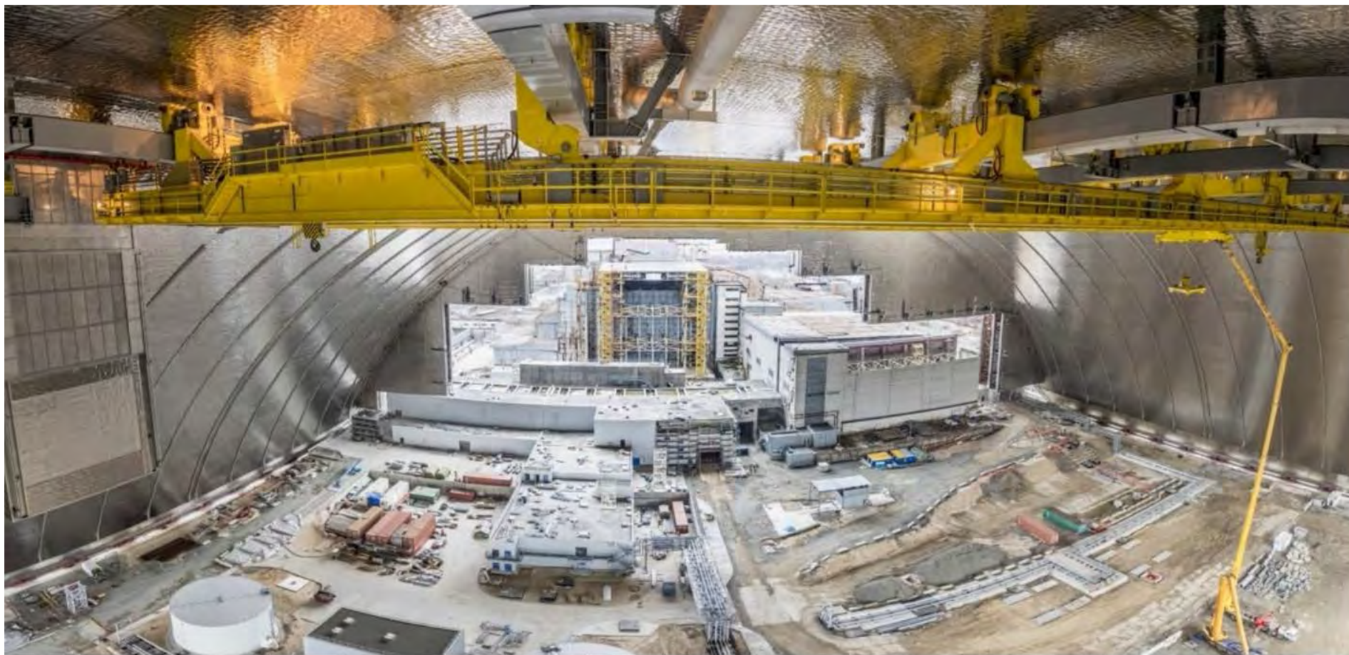
Рис. 64. Сборка системы основных кранов под «Аркой» на монтажной площадке (конструкции СОК окрашены в желтый цвет).
