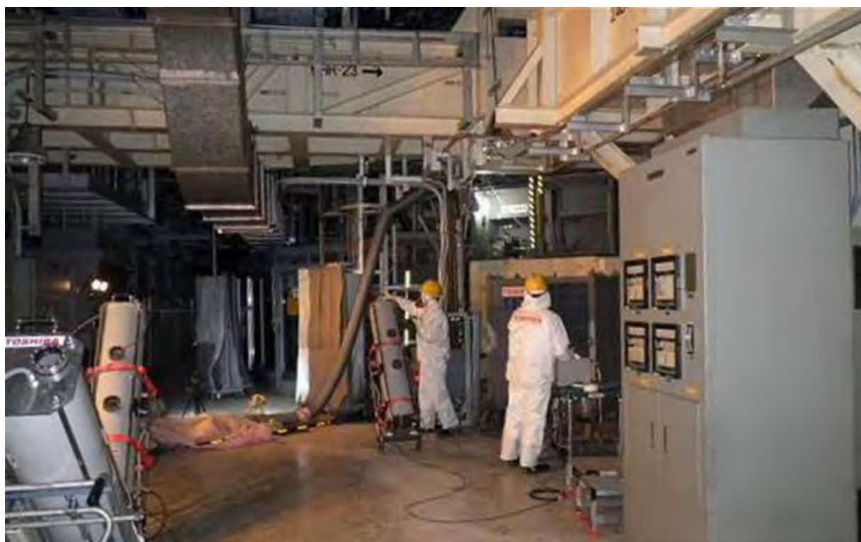
Рис. 125. На 2-ом блоке. Подготовка эндоскопа к работе.
