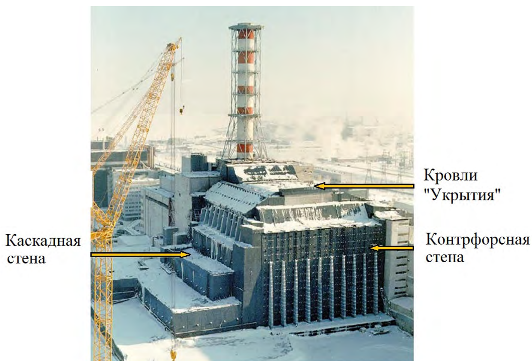
Рис.3. «Укрытие» 4-го блока ЧАЭС. Зима 1987г.
