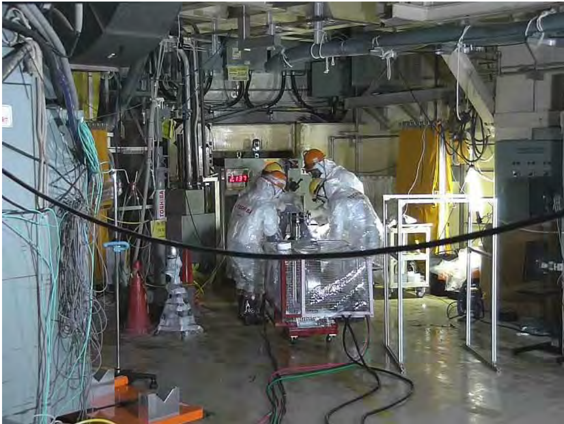
Рис. 152. Специалисты вводят робот БЗ в контейнмент 2-го блока.
