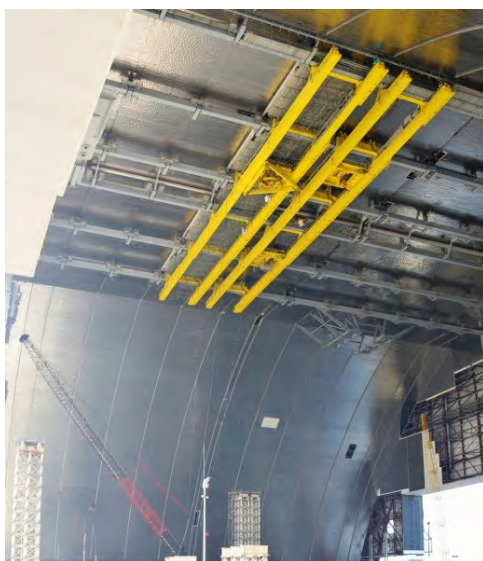
Рис. 62. Расположение СОК под «Аркой» и над объектом «Укрытие». Двутавровые балки крановых путей прикреплены снизу к нижнему поясу несущих ферм арочного типа.
