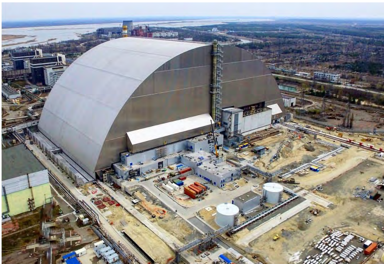
Рис. 57. «Арка» установлена над «Укрытием». Оснащается технологический корпус и возводятся вспомогательные сооружения и здания.
