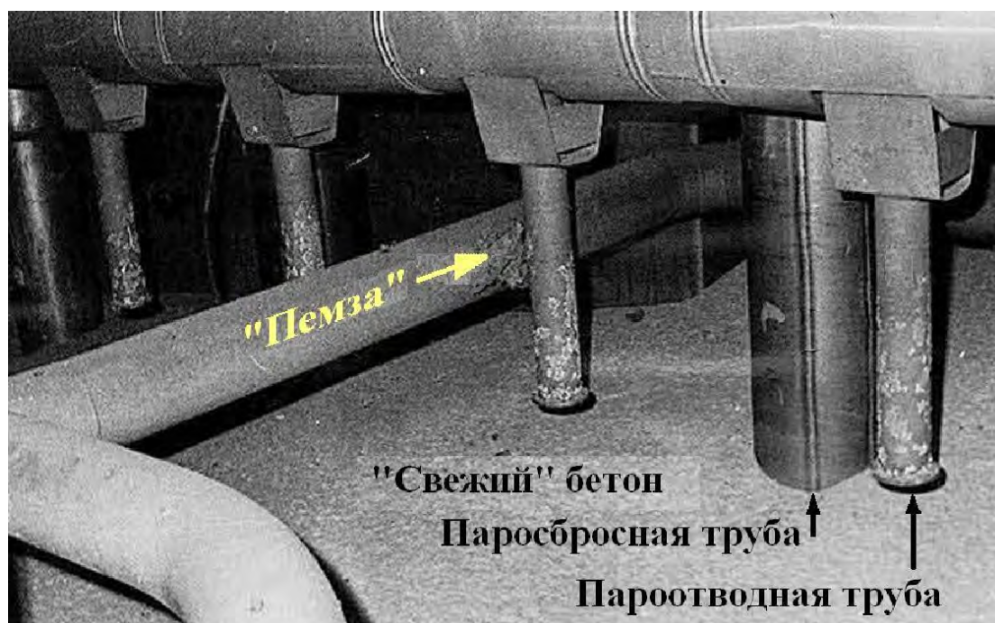
Рис. 91. Бетон, заливший нижние помещения.
