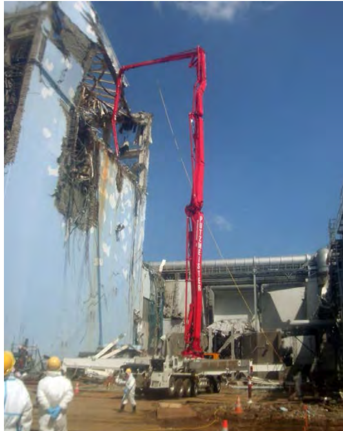
Рис. 103. Телеуправляемый Putzmeister с 62-метровой стрелой, работающий вблизи 4-го блока (начало апреля 2011 г.) Задача бетононасоса - разведка и подача воды в БВ.
