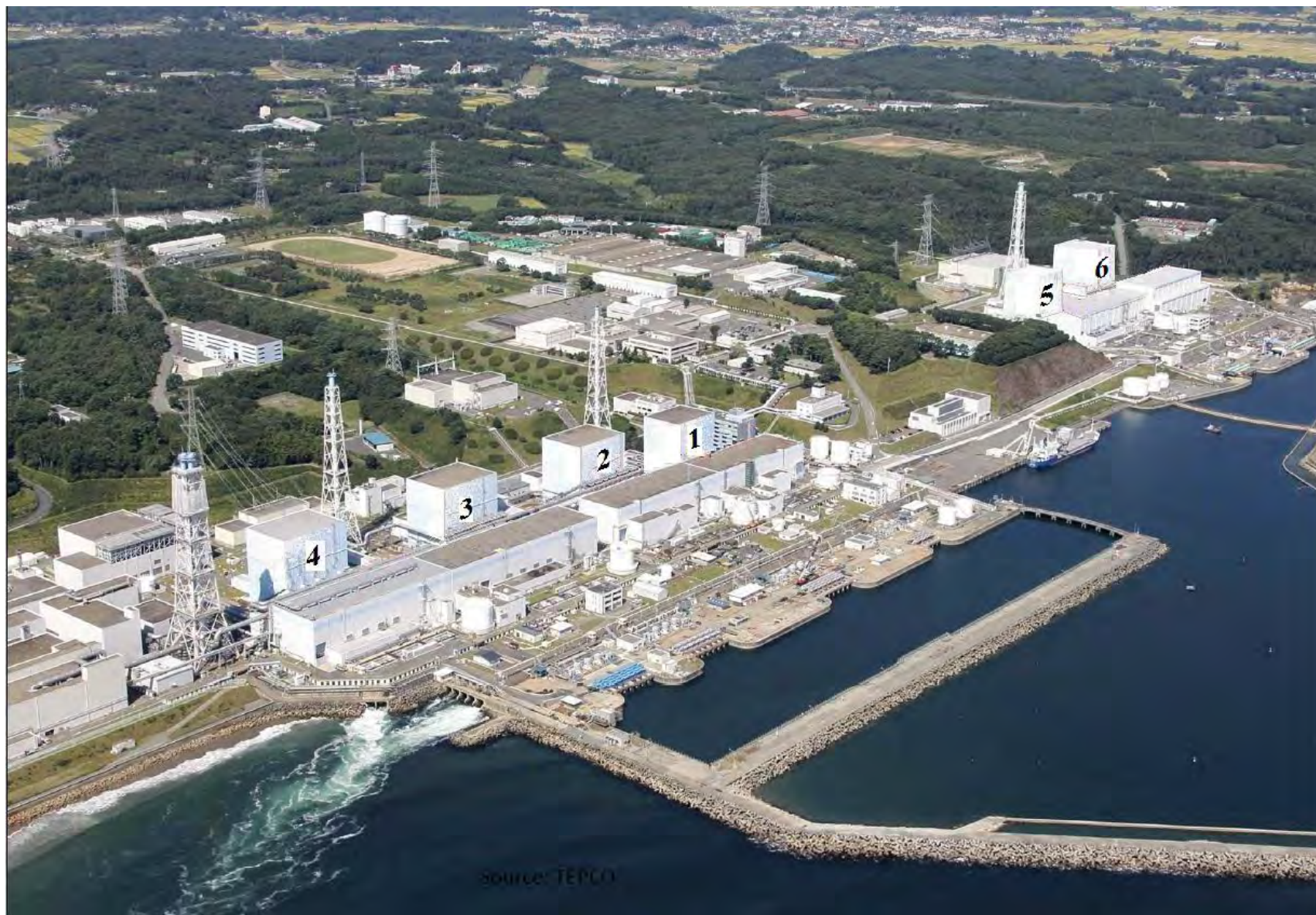
Рис. 95. АЭС Фукусима I до аварии.
