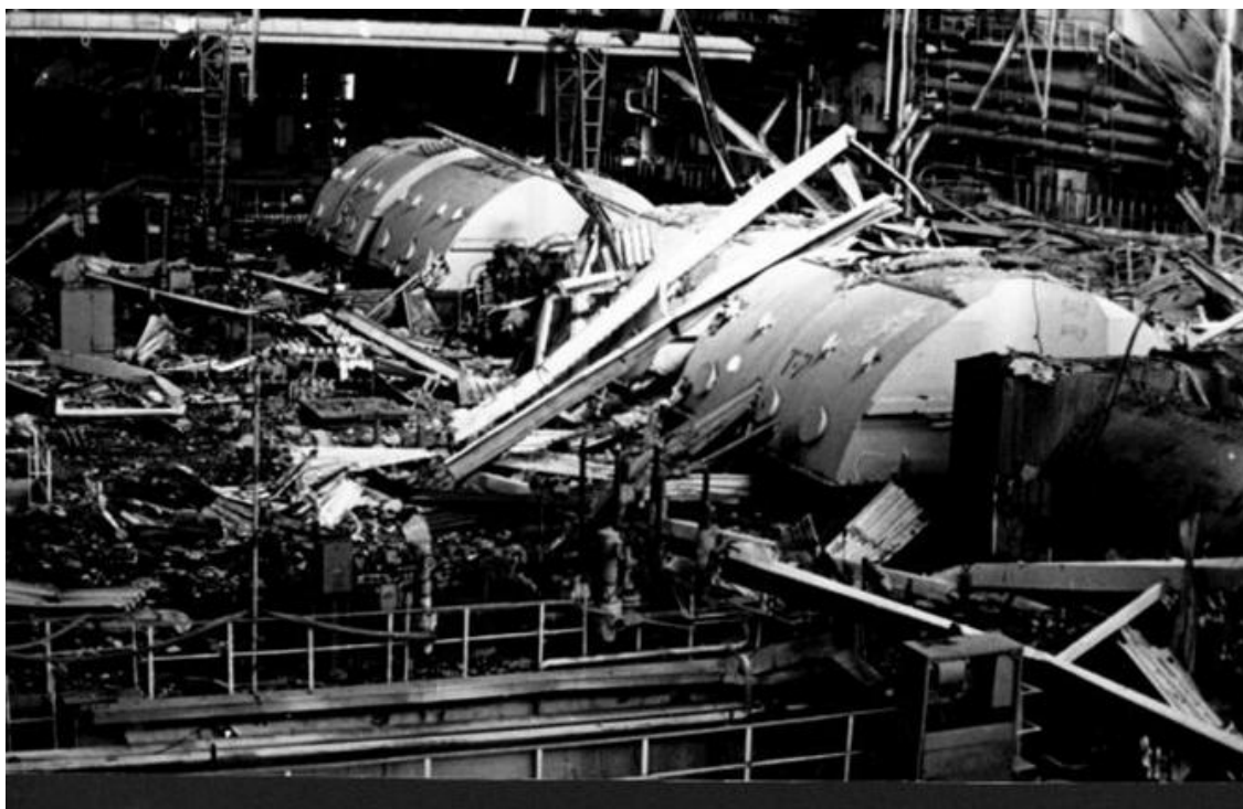
Рис. 37. 1986г. Машинный зал 4-го блока после аварии.
