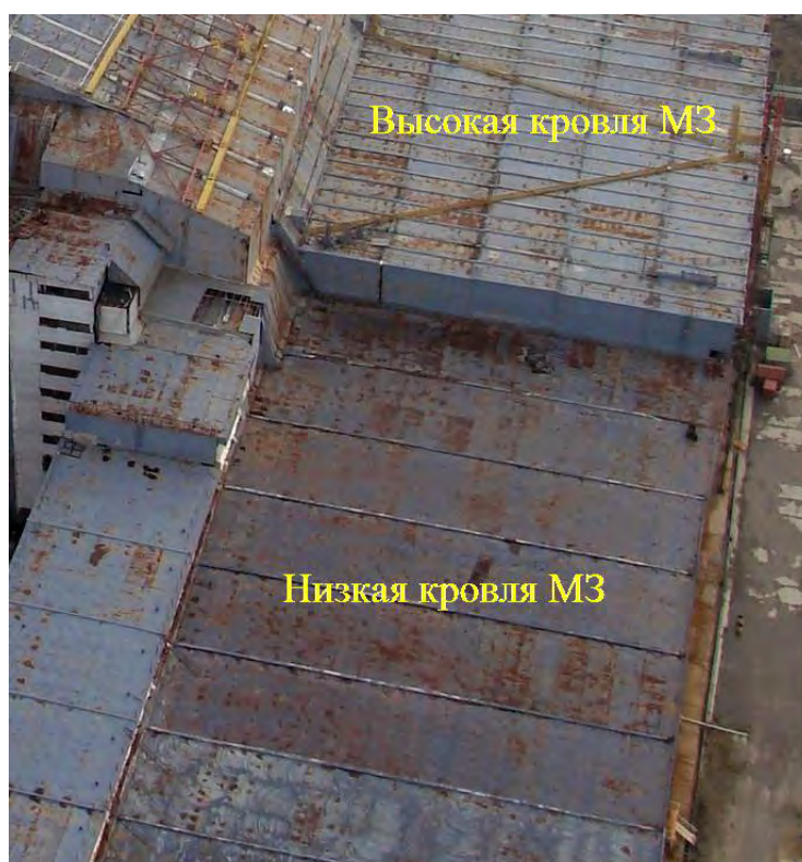
Рис. 40. Кровли машинного зала.
