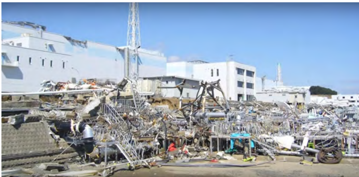
Рис. 101. Территория F-1 после аварии.
