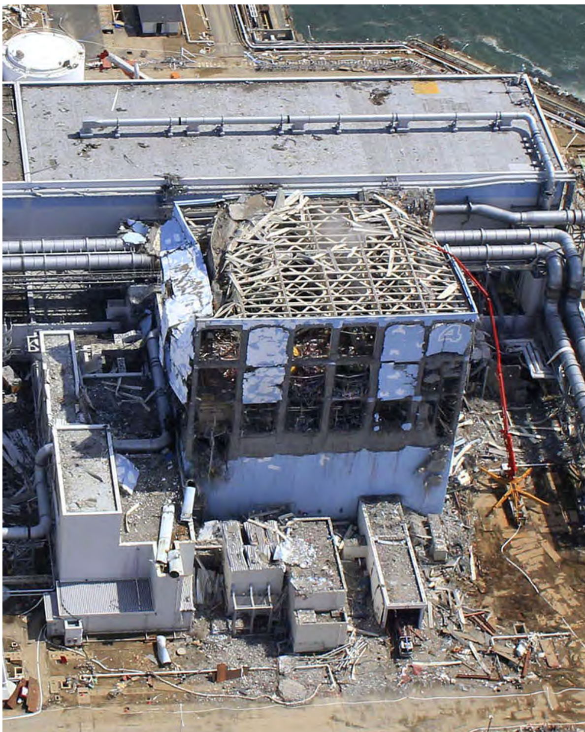
Рис. 122. Разрушенный 4-ый блок (один из снимков, сделанных с помощью T- Hawk).
