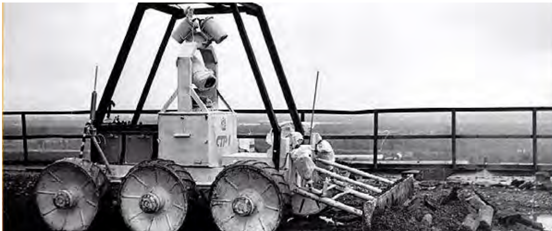
Рис.30. СТР-1 участвовал в очистке крыши на ЧАЭС от выброшенных при аварии радиоактивных материалов. Эксплуатировался при уровнях гамма-фона вплоть до 3000 Р/час.
