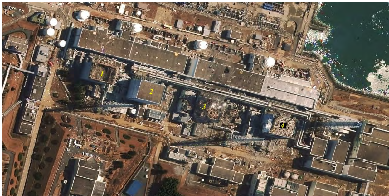
Рис. 11. F-1 после аварии. Разрушенные блоки. (20 марта 2011г.).
