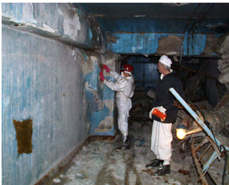
Рис.79. Подготовка одного из помещений «Укрытия», в котором предполагалось проводить работу с ТСМ. Нанесение полимерного состава с локализирующим действием на поверхность стен.
