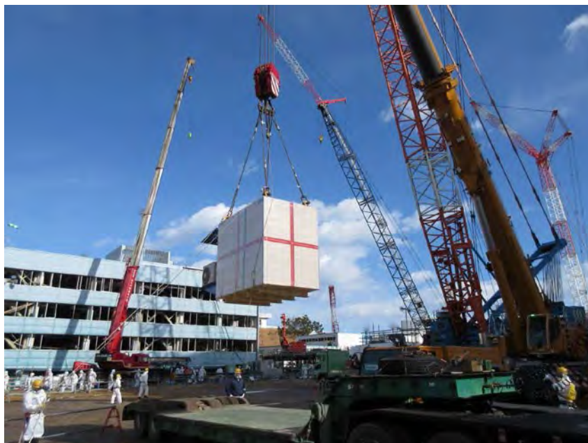
Рис. 162. Установка мюонного детектора на F-1.
