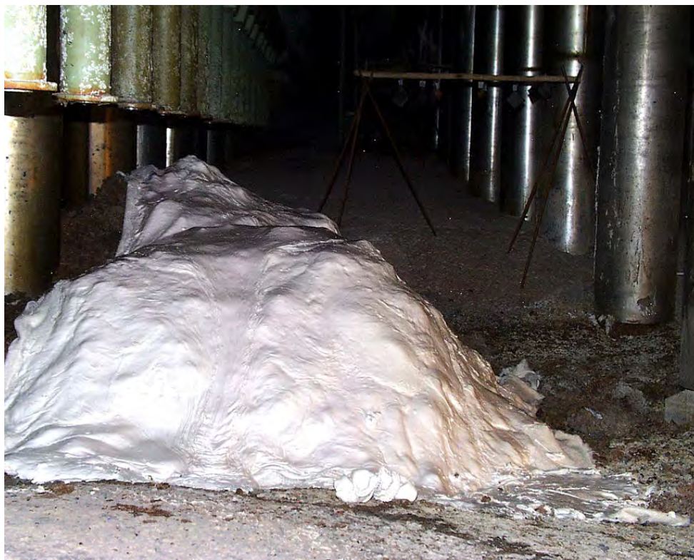
Рис. 82. «Куча» ЛТСМ на первом этаже бассейна-барботера, пом. 012/7, покрытая ЭКОР.
