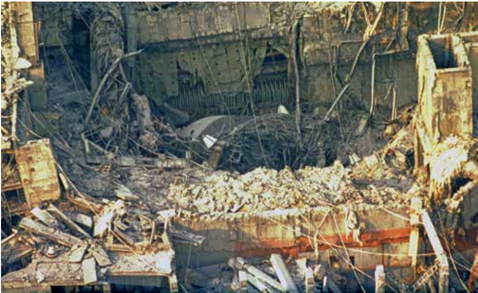
Разрушенный реактор 4-го энергоблока ЧАЭС
