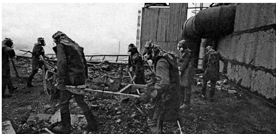
Очистка кровли 3-го блока в 1986 г. Фото: И.Ф. Костин/ РИА Новости
