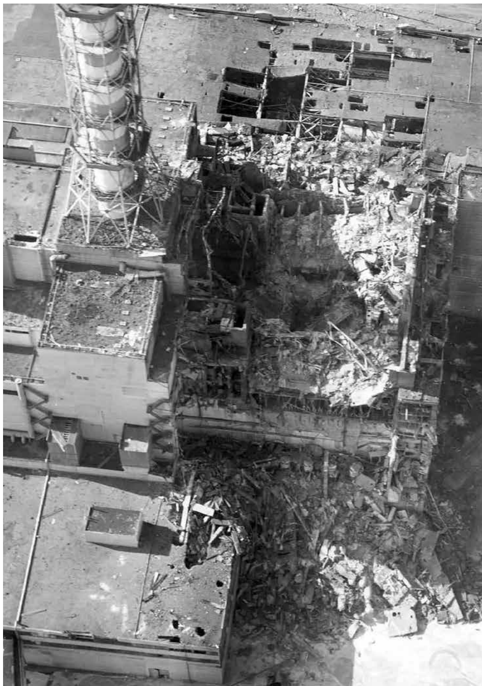
Разрушенный 4-й блок. Съемка 15 мая 1986 г.
