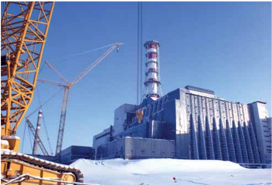
Чернобыльская АЭС, объект «Укрытие». Зима 1987 г.
