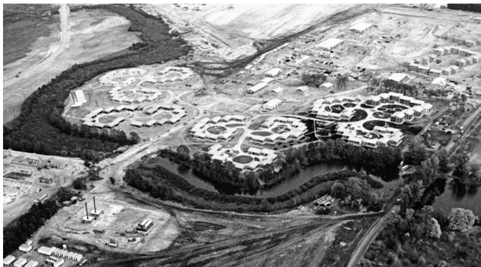
Вид с вертолета на строящийся г. Славутич
