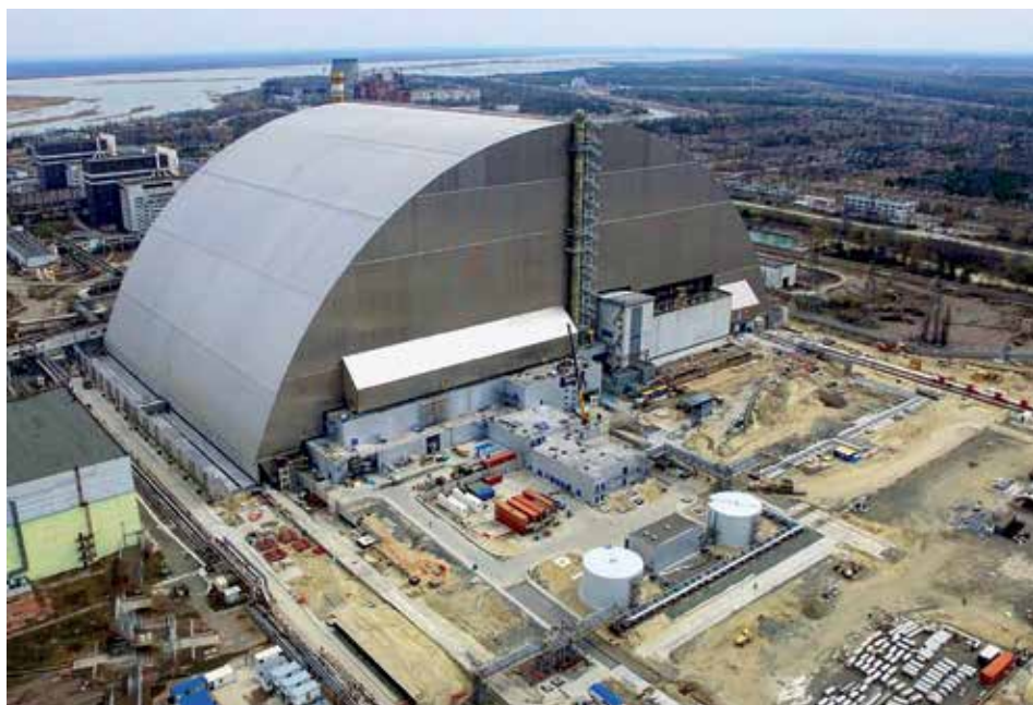
НБК, закрывший объект «Укрытие»
