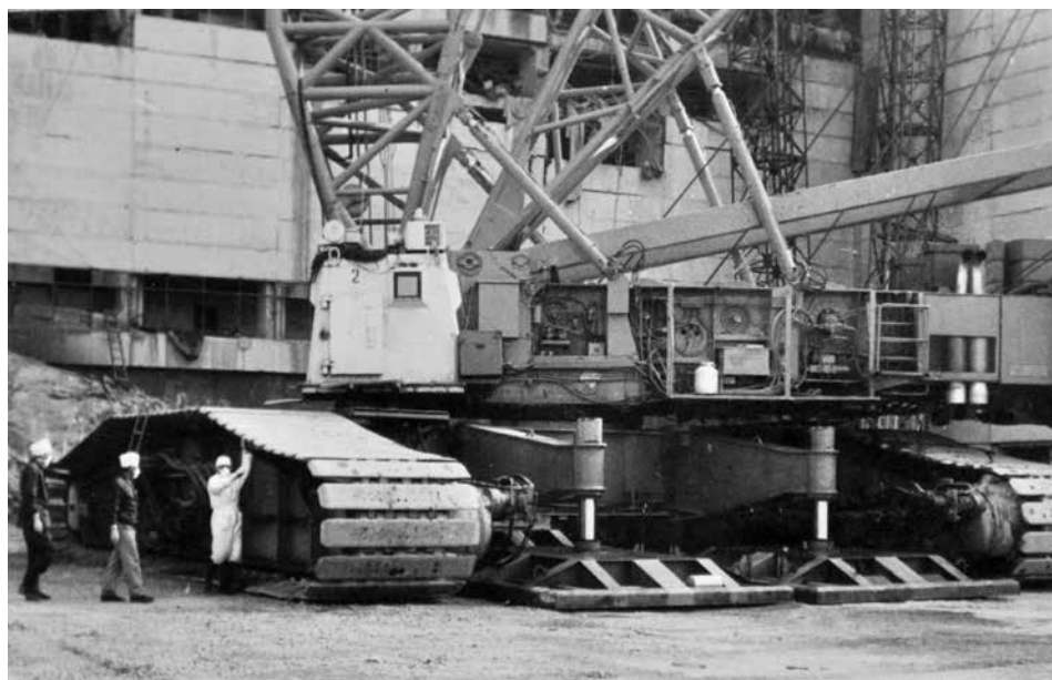
Строительство «Укрытия». У крана «Демаг», 1986 г.
