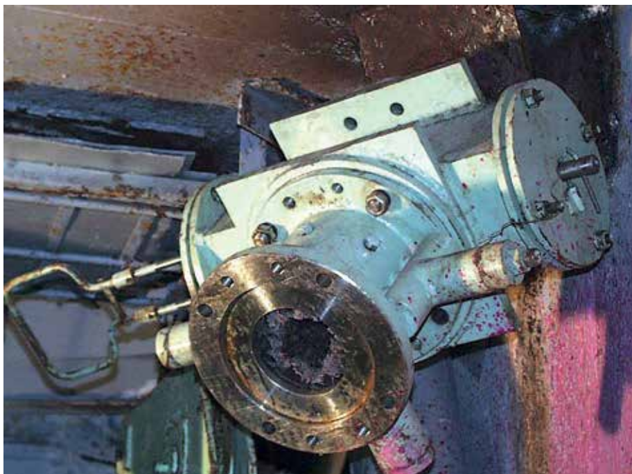
Пре́вентор скважины, обеспечивающий её герметичность
