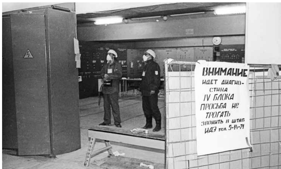
В одном из помещений 4-го блока
