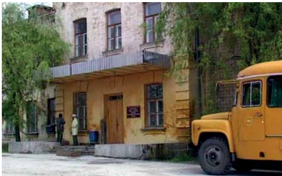
Лабораторный корпус в Чернобыле — двухэтажный корпус бывшего технического училища
