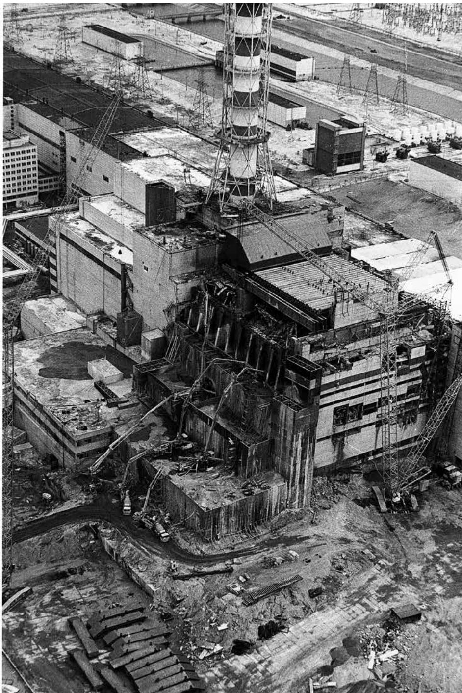
Дистанционная укладка бетона при строительстве «Укрытия»
