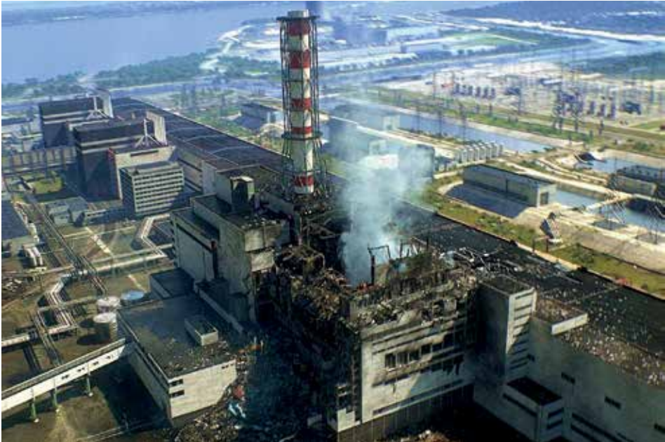
Развал разрушенного блока, вид с вертолёта
