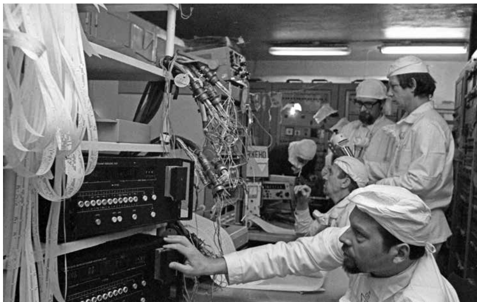
В «Укрытии». В пультовой управления системой диагностики объекта
