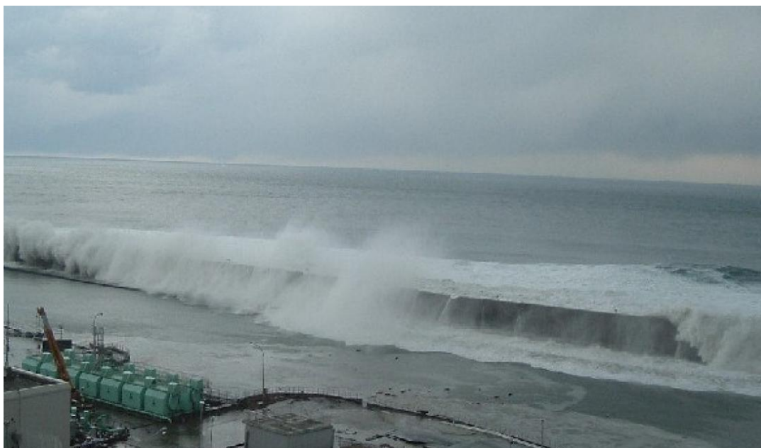
Рис. 35. Цунами преодолевает защитную дамбу (волнолом).
