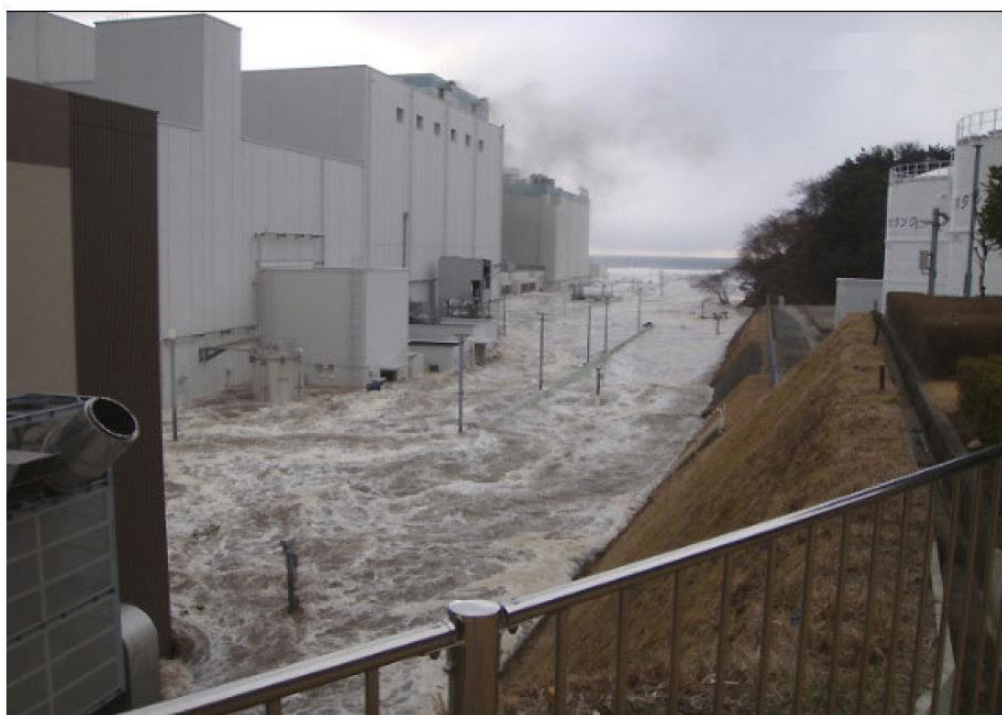
Рис. 36. Вода заливает АЭС Ф1.
