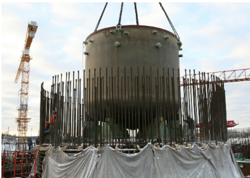
Рис. 29. На Ленинградской АЭС-2 начался монтаж устройства локализации расплава. В подготовленную шахту был установлен 160-тонный корпус ловушки (2009 г.).
