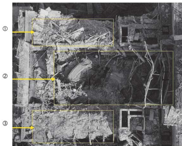
Рис.7. Верхние отметки блока после аварии. 1 и 3 - завалы на потолках помещений северного и южного барабан сепараторов; 2 – центральный зал.
