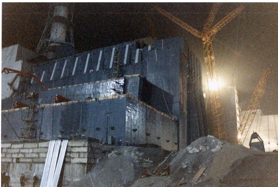
Рис. 30. Строительные работы на площадке ЧАЭС или круглосуточно.
