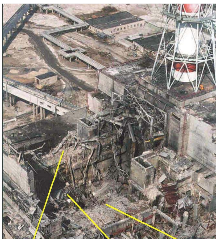
Рис.7. Верхние отметки блока после аварии. 1 и 3 - завалы на потолках помещений северного и южного барабан сепараторов; 2 – центральный зал.
